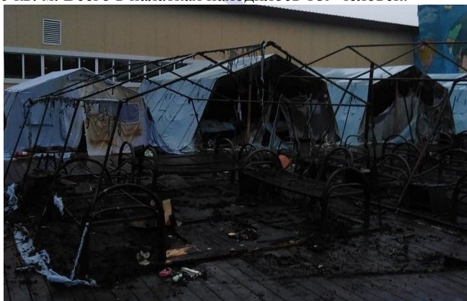
Рис. 7. Последствия пожара в палаточном лагере под Комсомольском-на-Амуре.
