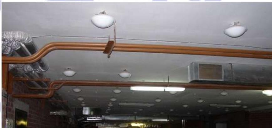
Рис. 22. Элементы установки порошкового пожаротушения модульного типа.
